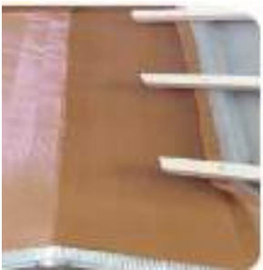
PASUL 6 Se continuă montajul contrașipcilor ce vor susține țigle ceramice. Se montează Tondach garnitură autoaderentă. În cazul unor debite de apă abundente, aceasta are tendința de a depăși marginile doliei și de a pătrunde în substructura învelitorii. Pentru a împiedica acest lucru de o parte și de cealaltă a doliei se montează garnitura autoaderentă pentru dolie.
