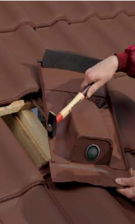
PASUL 1 Pentru țigle ceramice aplatizați falțul ca să asigurați un reazem solid al țiglei.
