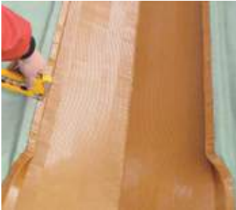
PASUL 5 Se fixează marginea doliei de tip rolă de șipcile montate anterior, folosind capse pentru construcții.
