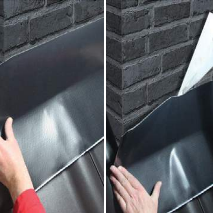
PASUL 1 Partea frontală a coșului de fum. Se taie o porțiune de bandă de etanșare de lungime egală cu lățimea frontală a coșului de fum la care se adaugă 4 cm de fiecare parte. După stabilirea poziției, banda de etanșare tăiată se îndoaie pe forma părții frontale a coșului de fum. Se îndepărtează folia de protecție a adezivului. Important! Lungimea benzii de etanșare pentru etanșarea părții frontale a coșului de fum este egală cu lățimea coșului de fum la care se adaugă 4 cm.
