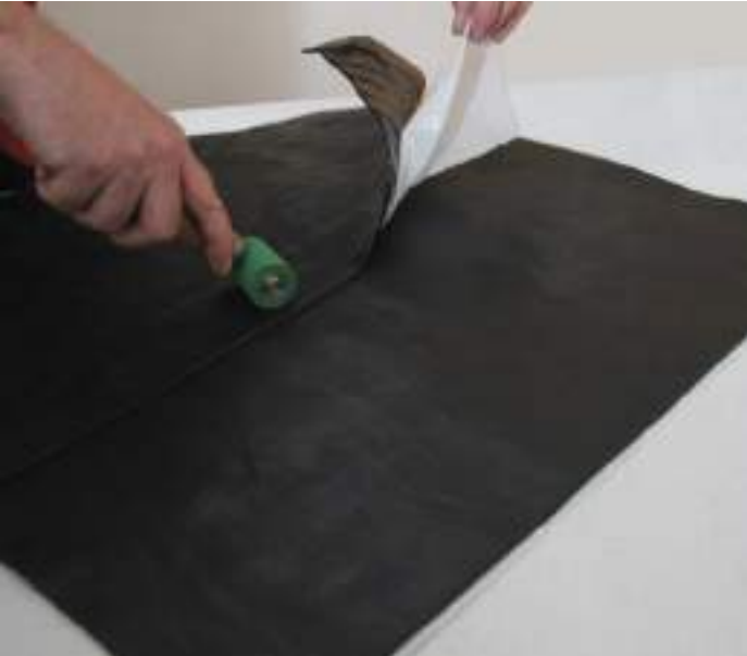
PASUL 6 Dacă este necesar se pot îmbina două porțiuni diferite de bandă de etanșare (lățimea minimă de suprapunere de 5 cm).
