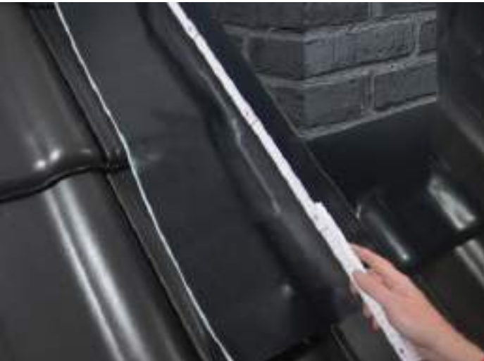
PASUL 4 Se taie porțiunile de bandă de etanșare ce se vor folosi pentru etanșarea părților laterale.
