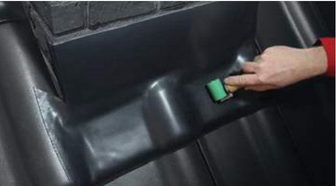
PASUL 3 Se fixează partea inferioară a benzii de etanșare (cea în contact cu țiglele ceramice) prin presare cu o rolă de nivelare.
