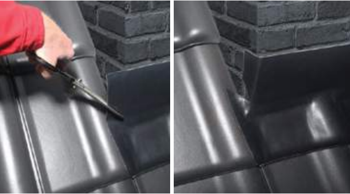
PASUL 2 Se decupează marginile laterale și apoi se presează pentru fixare.
