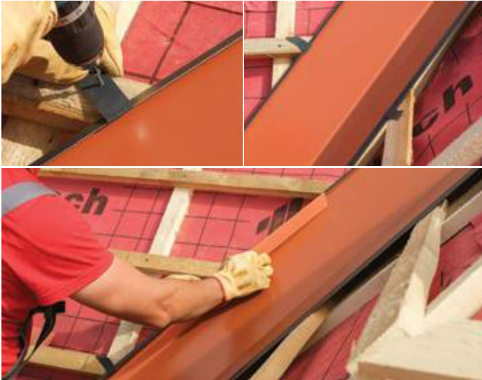
PASUL 2 Fixarea doliei de tip placă de șipci se face folosind agrafe confecționate din aluminiu. Un capăt al agrafei metalice se agață de marginea doliei (pre-îndoită din procesul de fabricație), celălalt capăt al agrafei se bate/înșurubează în șipcă, printr-un cui sau holșurub. Dolia de tip placă se fixează cu agrafe metalice în zonele șipcilor (2-3 buc/ml/laterală) și în zonele de suprapunere. Lungimea de suprapunere a plăcilor de dolie, în cazul unei lungimi mai mari decât cea a plăcii, depinde de înclinația (panta) acoperișului astfel: ▪ panta acoperișului > 22° - min. 10 cm ▪ panta acoperișului < 22° - min. 15 cm În cazul unor debite de apă abundente, aceasta are tendința de a depăși marginile doliei și de a pătrunde în substructura învelitorii. Pentru a împiedica acest lucru de o parte și de cealaltă a doliei se montează garnitura autoaderentă pentru dolie.
