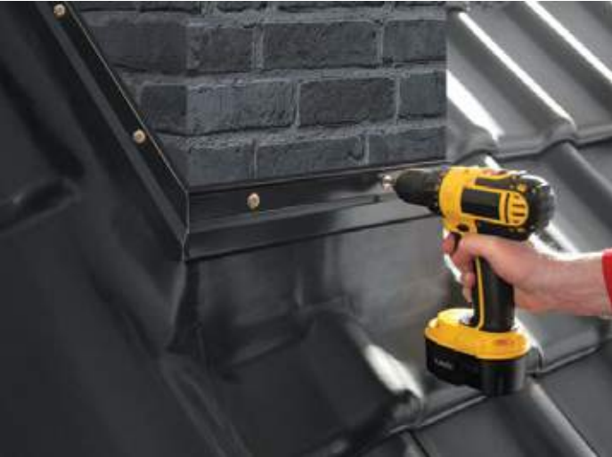
PASUL 8 Etanșare adițională cu Tondach Bară etanșare horn/perete. Tondach bară de etanșare horn/perete se va fixa cu holșuruburi. Îmbinările se pot sigila cu silicon pentru construcții. Atât banda cât și bara de etanșare se pot folosi împreună pentru etanșarea tuturor situațiilor exemplificate în imaginea de prezentare de mai jos – marcaj culoare portocaliu.
