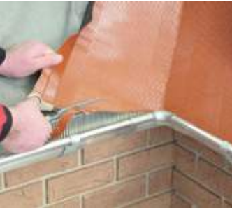
PASUL 4 Se taie din dolia de tip rolă lungimea dorită și se îndoaie marginea acesteia urmărind liniile predefinite.
