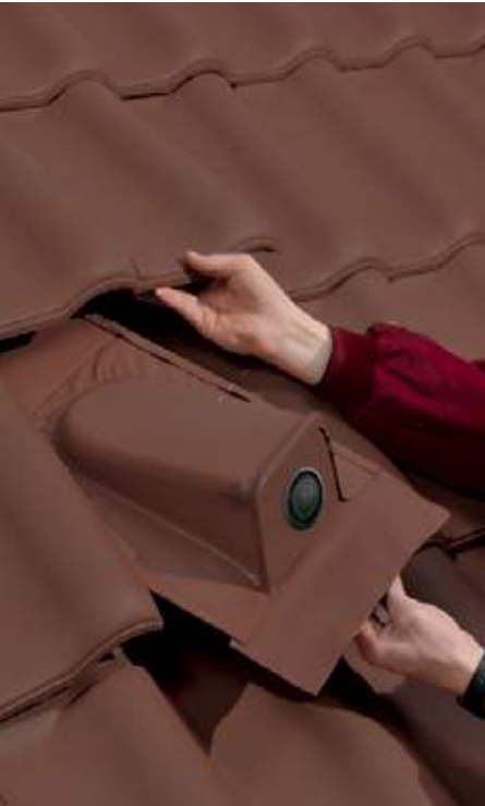
PASUL 2 Introduceți elementul de străpungeri și aveți grijă să fie montat sub țigle pe toate cele trei laturi.
