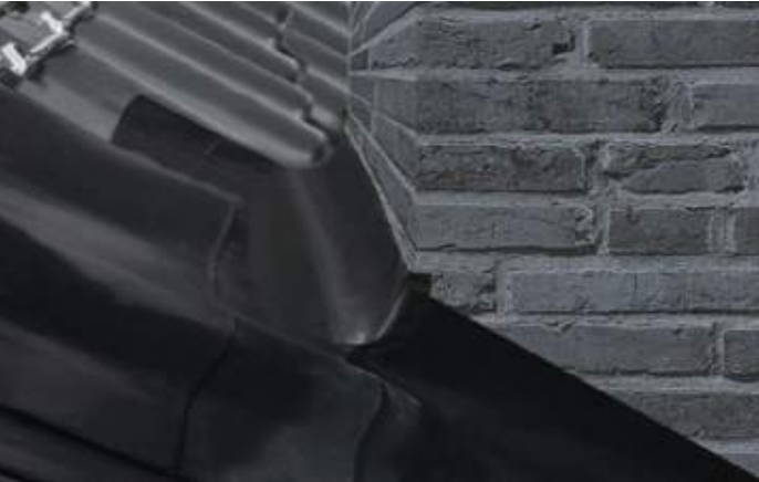
PASUL 7 Partea din spate a coșului de fum. Banda de etanșare horn/perete, în această zonă, se montează direct pe astereală sau pe o placă de lemn. În cazul pantelor pronunțate se recomandă folosirea unei plăci de lemn cu profil triunghiular. Înălțimea plăcii de lemn trebuie să fie egală cu cea a țiglelor vecine. Important! Lungimea benzii de etanșare din această zonă trebuie să depășească suprafața suport cu 10 cm până la 20 cm pentru asigurarea etanșeității. Bucata de bandă de etanșare care depășește suprafața suport va fi acoperită de țigla de bază montată pe rândul imediat superior suprafeței suport.
