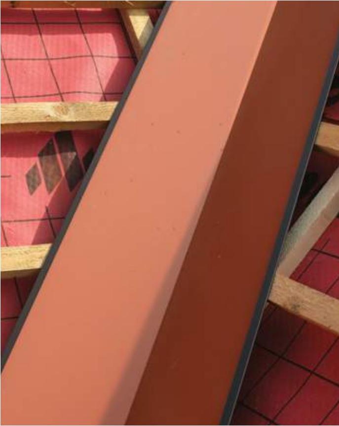
PASUL 1 Dolia de tip placă se poziționează în zona de dolie, după ce în prealabil au fost montate folia de difuzie și rețeaua de șipci și contrașipci.
