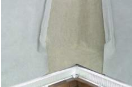
PASUL 3 Folia de difuzie decupată și montată pe versanții ce mărginesc zona doliei trebuie să îmbrace cele două șipci montate la pasul anterior.
