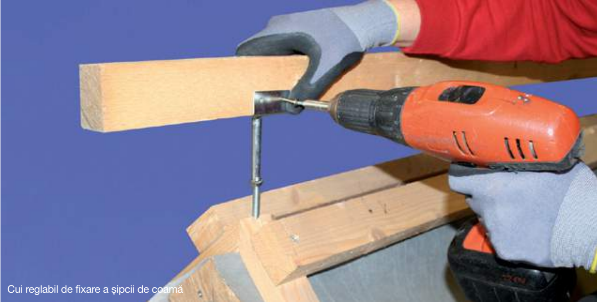
Cui reglabil de fixare a șipcii de coamă
